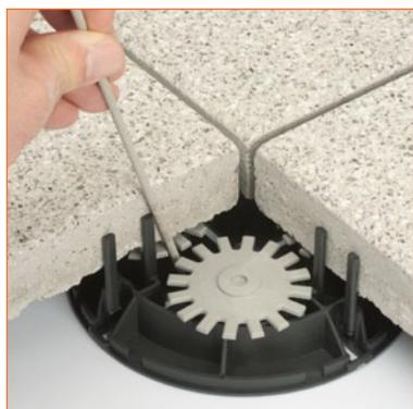
Mittels eines Schweißdrahtes kann die Feinjustierung der Plattenhöhe an den Stellrädern vorgenommen werden.
