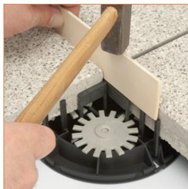
Durch die stramme Verlegung der Platten kann man zum Einbauen der Fugenkreuze als zusätzliche Hilfe ein 3 mm dickes Stück Holz und einen kleinen Hammer benutzen.
