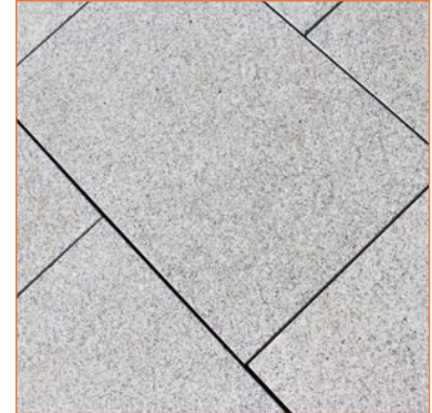
Příklad pokládky s podélným překrytím
